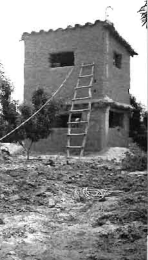
Abri d'une installation électrique alimentant une pompe et un puits d'irrigation dans un verger de pêchers, financés par la migration internationale (Arbieto).
