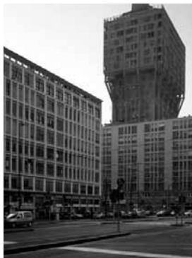
BBPR, Torre Velasca. Foto Marco Introini BBPR, Tour Velasca. Photo Marco Introini
